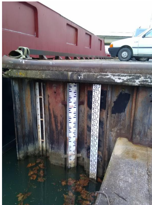
Figure 43 - Echelles limnimétriques non utilisées, port de Bray-sur-Seine
